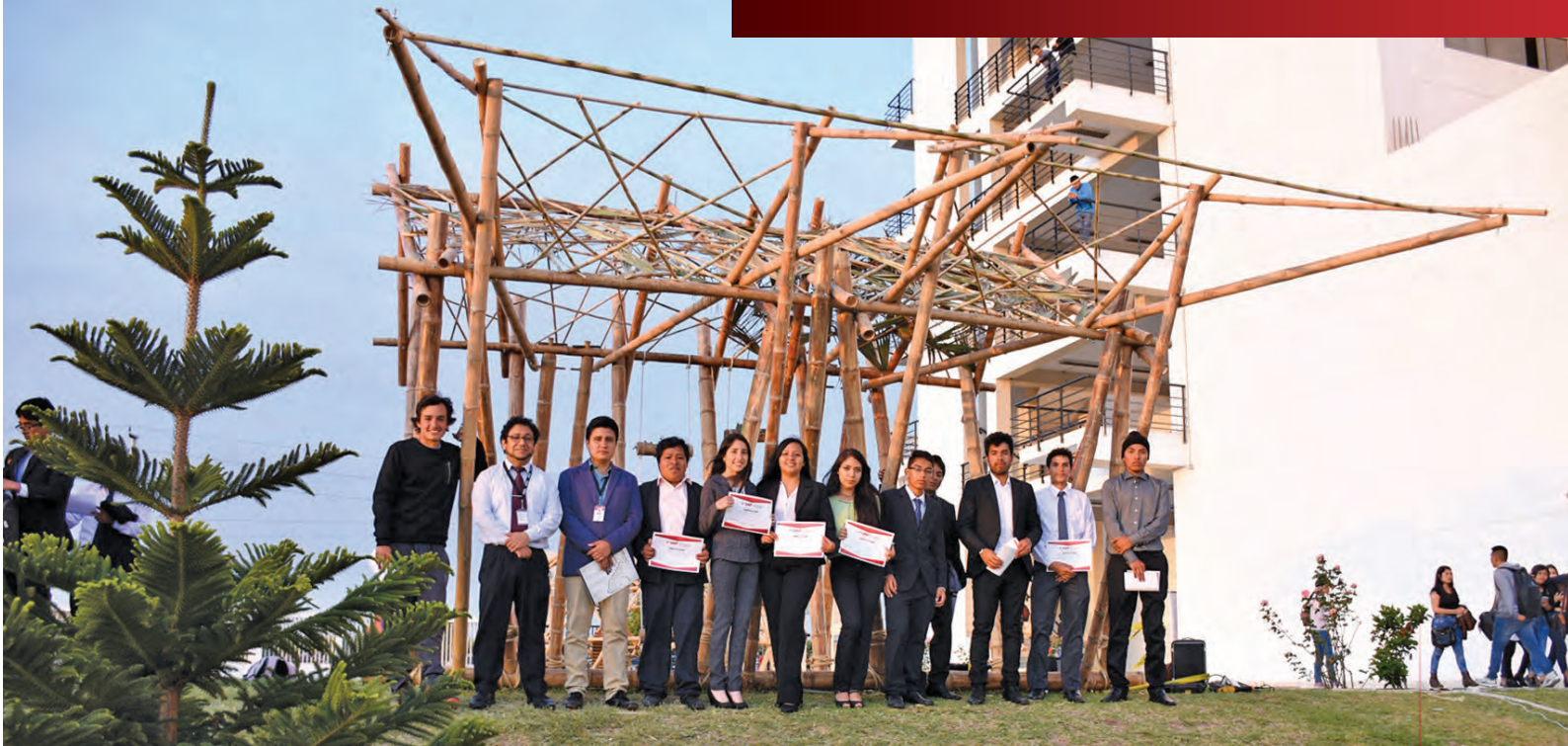
■ Filial Huacho. Construcción de Módulo de Sol y Sombra elaborado con materiales naturales.
